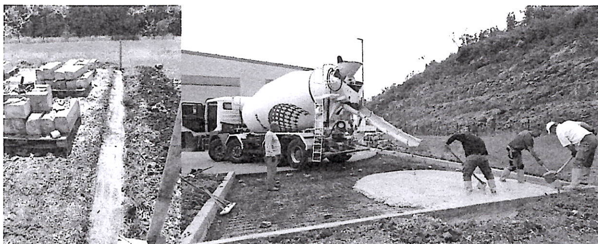
Slika 3. Priprema terena, postavljanje ivičnjaka i izlivanje platoa
